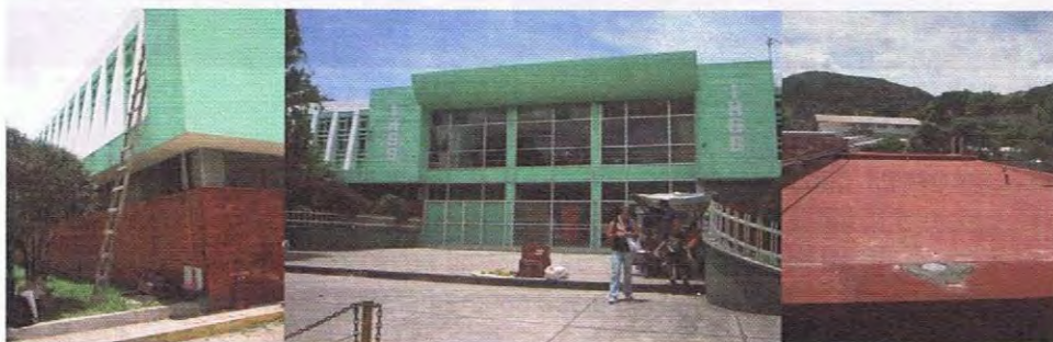
Figura 8.- Vértice del IHSS, en la azotea del edificio, acceso con escalera
