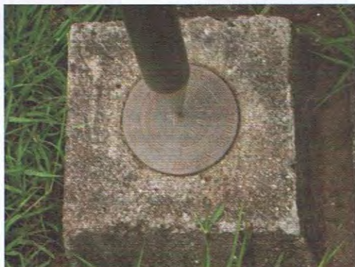
Figura 4.- Señal perteneciente al vértice del observatorio construida en la campaña geodésica de EE.UU. del año 1994
