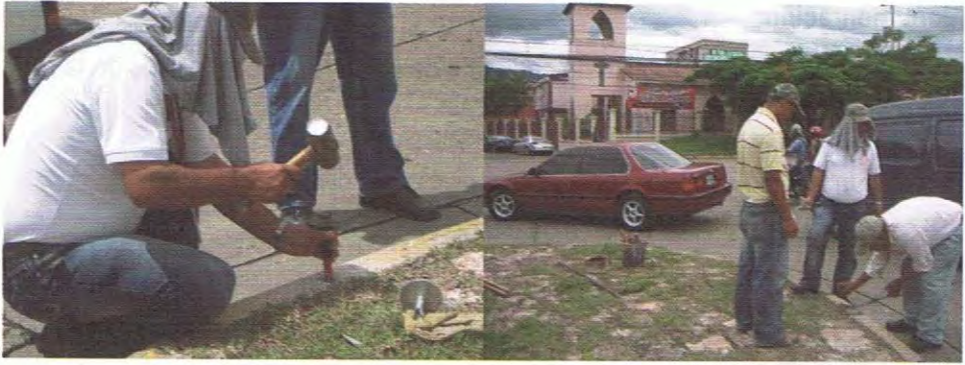
Figura 9.- Trabajos de monumentación
