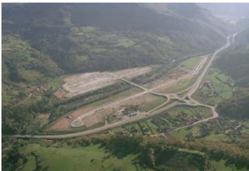
Figura 6: Vista aérea de la ejecución de las obras de urbanización de Argame (Asturias)
