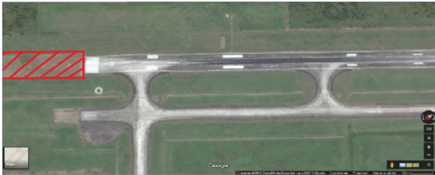
Figura 3. El extremo de la pista 22 mostrando ausencia de (RESA) RUNWAY END SAFETY AREA
