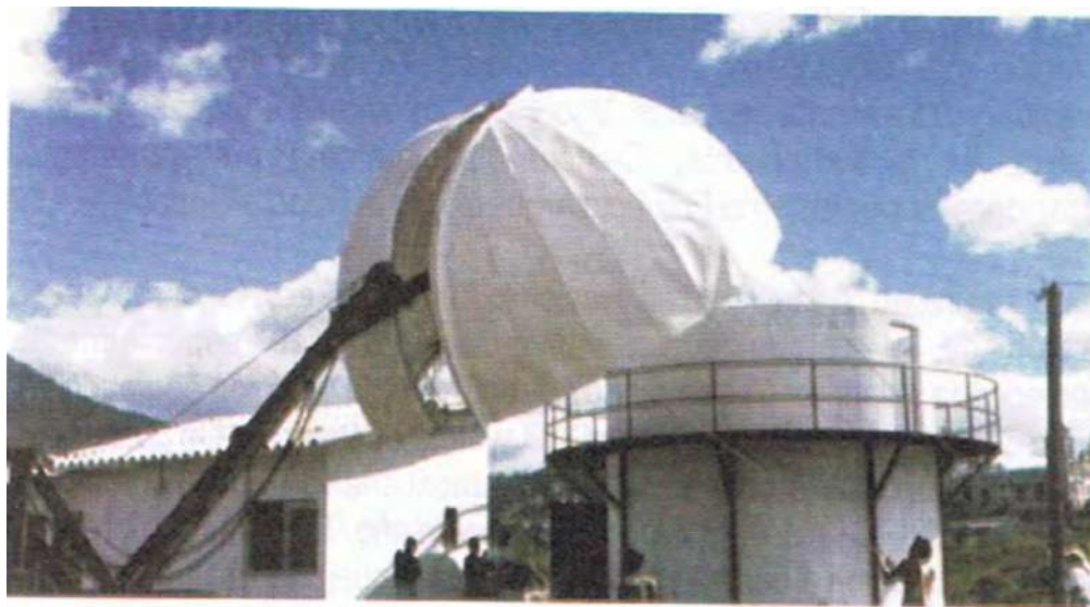
Figura 2: Instalación de la cúpula del Observatorio Astronómico de la UNAH. Tomado de Pineda de Carías (2009b) .
